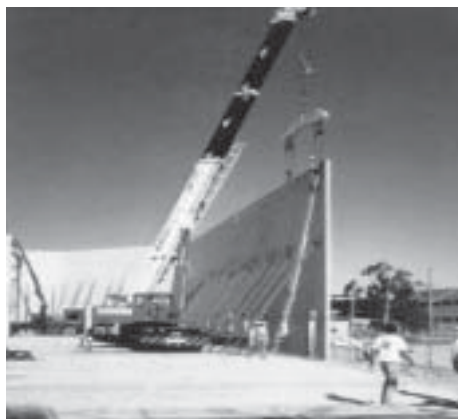
Foto 14 - Posicionamento de painel utilizando escoras provisórias (foto: MEDEIROS, 1996).
