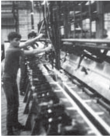
Foto 42 - Aplicação de espuma na vertical (BROOKES, 1998).
