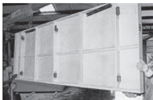
Foto 26 - Nervuras para enrijecimento de painéis planos de GRC (PCI, 1995).
