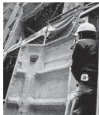
Foto 27 - Nervuras para enrijecimento de painéis curvos de GRC (PCI, 1995).
