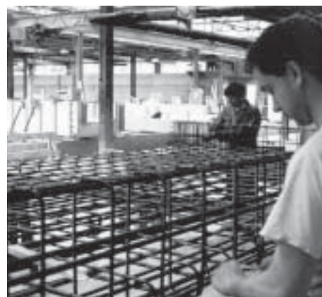
Foto 9 - Armação do painel. (foto: Dawson, 1995)
