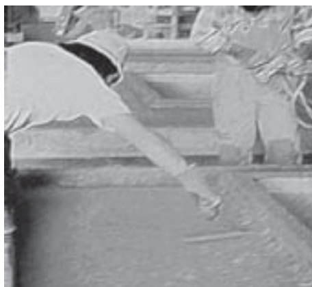
Foto 25 - Painel em adensamento manual (PCI, 1995).
