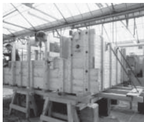
Foto 8 - Escoramento lateral para evitar empenamento lateral. (foto: Dawson, 1995)
