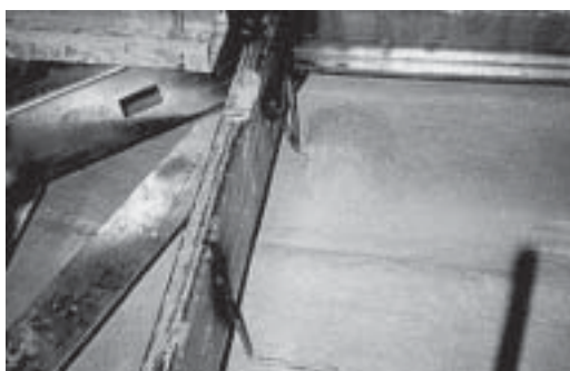
Foto 28 - Posicionamento do enrijecimento metálico a painéis GRC (PCI, 1995).
