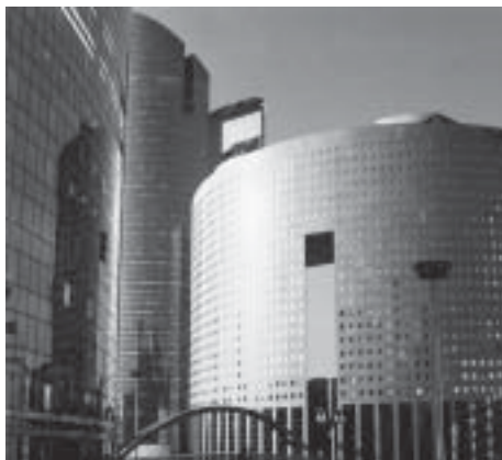
Foto 4 - Edifício em painel de concreto, La Defense, Paris (foto: Vanessa Gomes).
