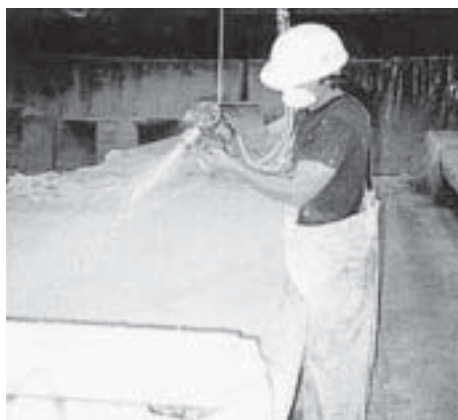
Foto 24 - Painel sendo produzido por projeção (PCI, 1995).
