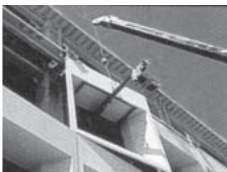
Foto 33 - Colocação de painel com esquadria recuada em relação ao plano da fachada (PCI, 1995).
